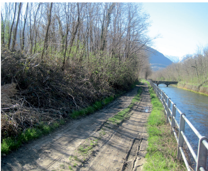
Sponda in sinistra idrografica del canale artificiale
